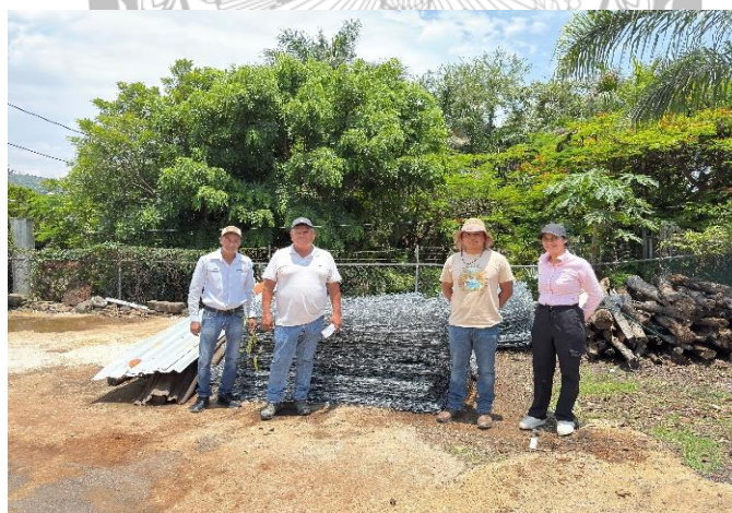
Figura 16. Recepción de mayas de gavión para proyecto de represas.
